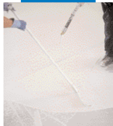
Application d'Ultratop à la machine
