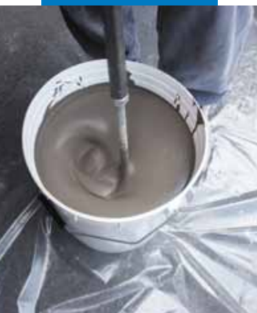
Préparation du produit avec un malaxeur
