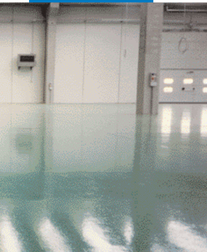
Exemples de sols finis réalisés avec Ultratop
