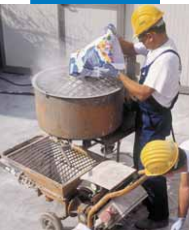
Préparation du produit à la machine avant le pompage
