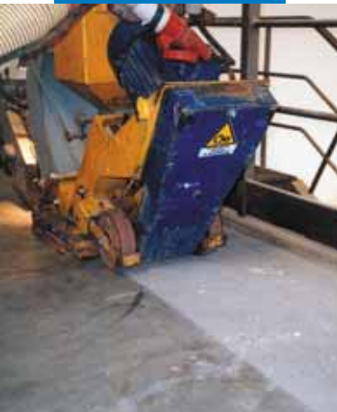
Préparation du support au moyen d'un grenailleur
